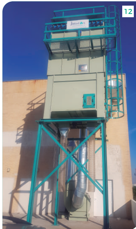
06 • 09 Filtro FM • FM Filter Limpieza/Limpieza Auto por Motovibrador Motovibrador Auto Cleaning
